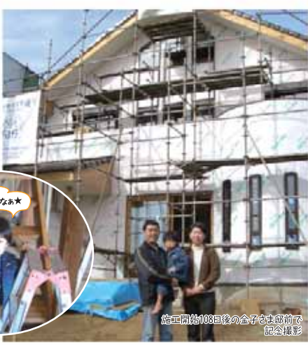
▲ 建築中の金子様邸。壁に見える白いものは、建築中の雨風を防ぐ「防風透湿シート」です。この他にも様々な工程を経て、丁寧に外壁が作られていきます。
