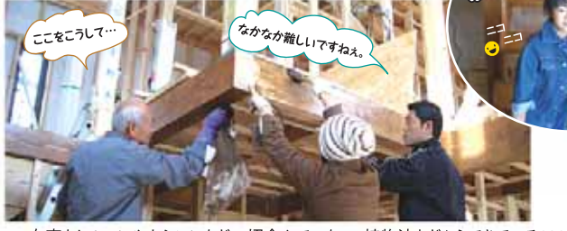
▲ 建築中の金子様邸。壁に見える白いものは、建築中の雨風を防ぐ「防風透湿シート」です。この他にも様々な工程を経て、丁寧に外壁が作られていきます。
